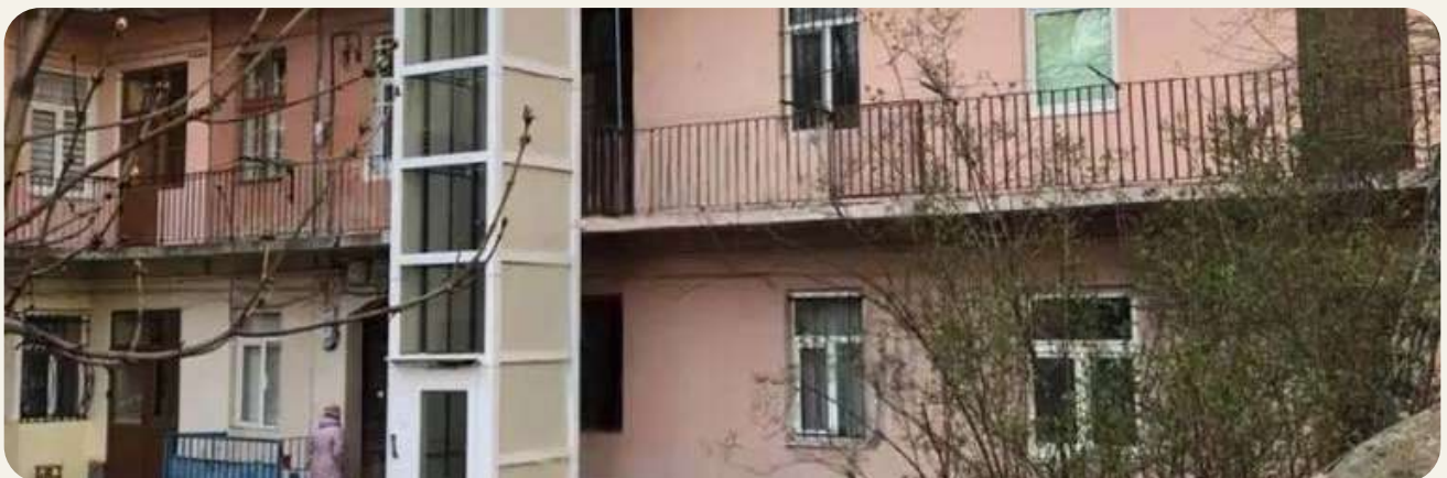
Рисунок 1.33. Приклад прибудови ліфта до галереїного будинку
