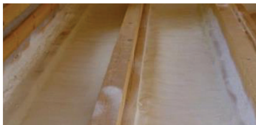
Рисунок. Утеплення пінополіуританом. Утеплення горища мінераловатними плитами.
